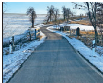
Auch von der Kreisstraße K 8070 bis zum Ortseingang Tronitz wurde das Teilstück komplett erneuert. Hier wurden nur an verkehrstechnisch wichtigen Bereichen Leitpfosten gesetzt. In den übrigen Straßenbereichen konnte dies nicht umgesetzt werden, weil die Straße zu schmal ist.
