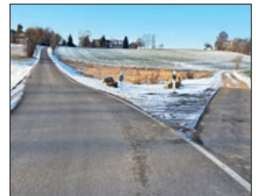
Auch von der Kreisstraße K 8070 bis zum Ortseingang Tronitz wurde das Teilstück komplett erneuert. Hier wurden nur an verkehrstechnisch wichtigen Bereichen Leitpfosten gesetzt. In den übrigen Straßenbereichen konnte dies nicht umgesetzt werden, weil die Straße zu schmal ist.
